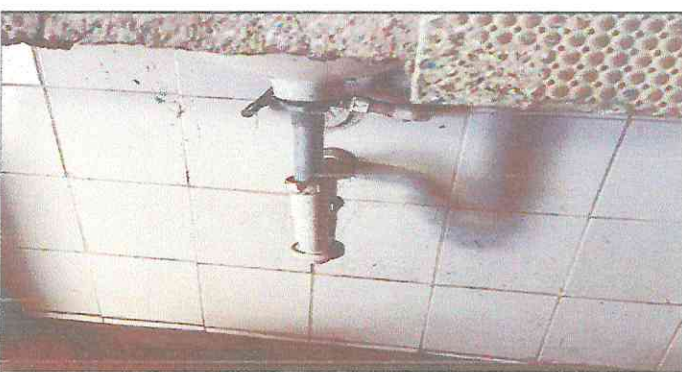
Foto 6: Arreglo de baños
