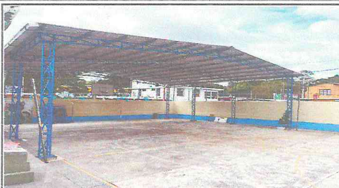
Foto 2: Estructura metálica y techado de cancha
