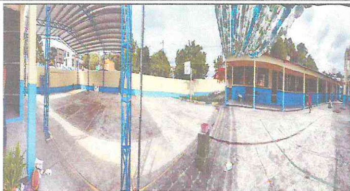
Foto1: Bases para estructura metálica
